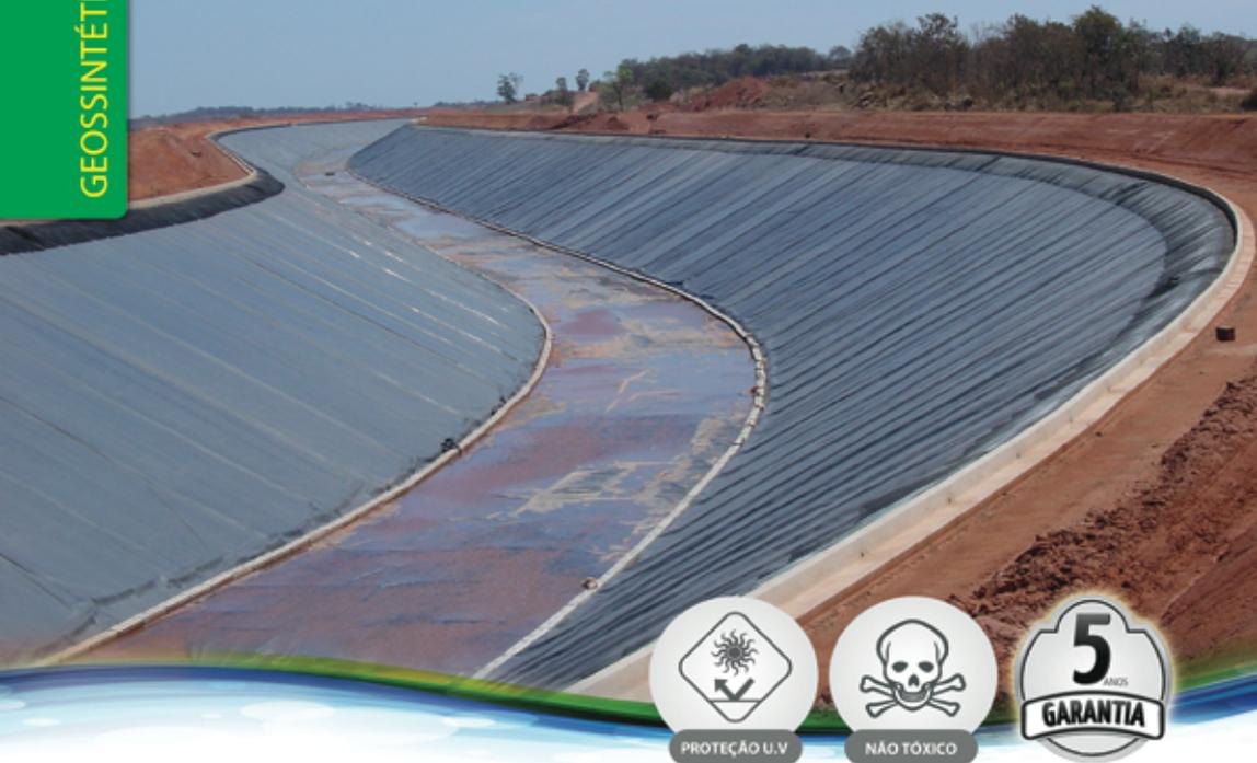
Os reservatórios são desenvolvidos em geomembrana de polietileno de alta durabilidade, não tóxico e com garantia de estanqueidade devido ao sistema de solda por termofusão. Os tanques podem ser pré-fabricados e disponibilizados aos clientes com manual de instalação ou montados no local por uma equipe de instaladores.
